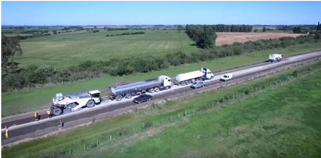
Figura 10. Tren de reciclado en sitio
