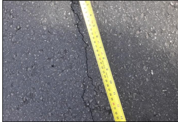
Figura 11. Fisuración encontrada en mezcla asfáltica
