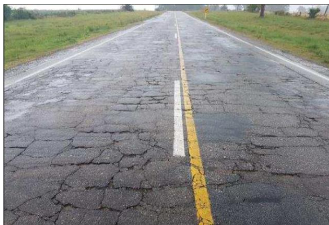
Figura 2. Estado previo del pavimento a rehabilitar
